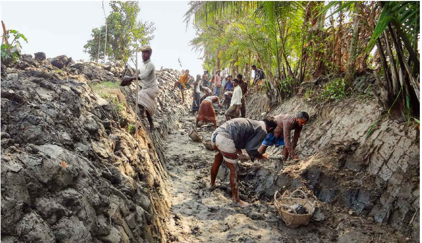
Soziale Mobilisierung ist auch Teil des Projekts: Statt auf die Hilfe der Regierung zu warten, heben einige Dorfbewohner nun selbst Kanäle aus oder reparieren Deiche, um ihre Äcker vor Überschwemmungen zu schützen.
